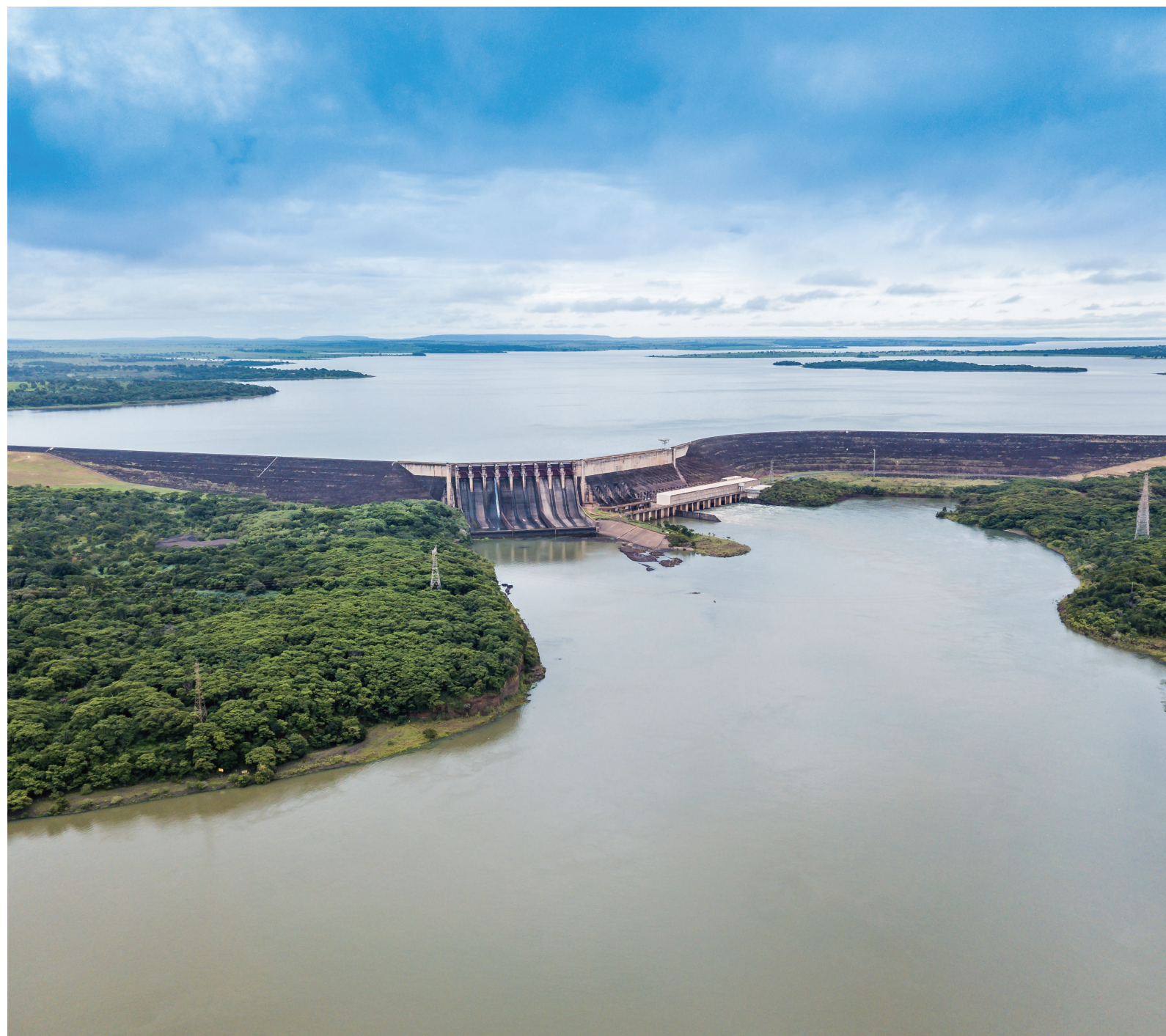
巴西圣西芒水电站
