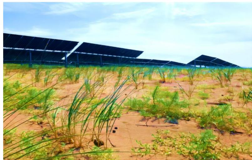
东北公司敖润苏莫15万千瓦光伏治沙项目通过建设32.677万片光伏组件和布置固沙草方格，有效形成防风阻沙隔离带，促进场区植被生长，改善当地生态环境。
