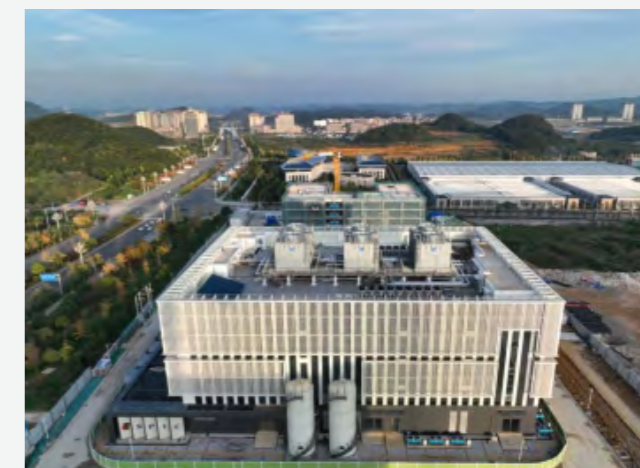
国家电投贵安数据中心 SPIC Gui'an Data Center
