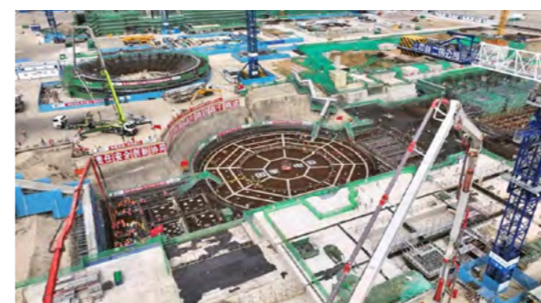
国家电投山东海阳核电 4 号机组浇筑核岛第一罐混凝土 (FCD) FCD for Unit 4 of SPIC Haiyang Nuclear Power Plant in Shandong
