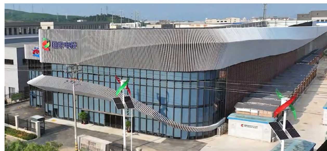
国家电投浙江湖州综合智慧零碳电厂项目一期 SPIC SEP Phase I in Huzhou, Zhejiang
