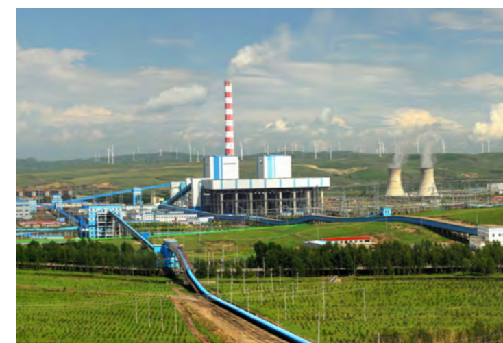
国家电投内蒙古霍林河坑口发电公司 SPIC Huolinhe Pit-mouth Power Plant in Inner Mongolia
