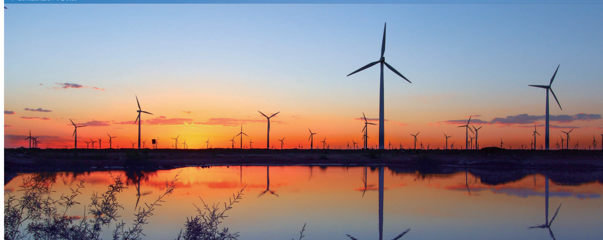
中电新能源酒泉风电项目
