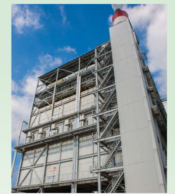
超洁净排放改造主要设备——湿式除尘器
