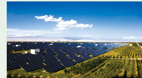
光伏电站恢复的植被带
