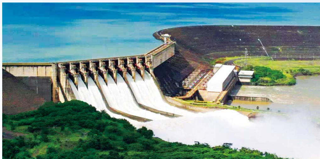
巴西圣西芒水电站
