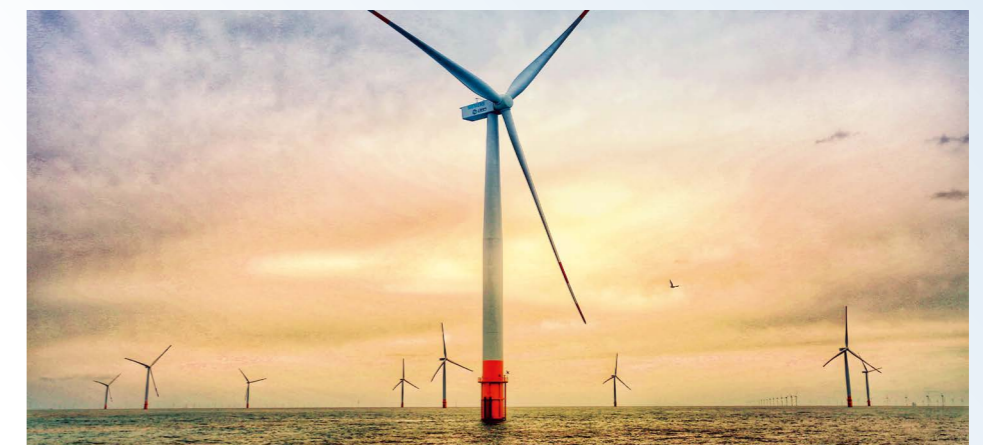
国家电投江苏滨海北 H1#100MW 海上风电场
