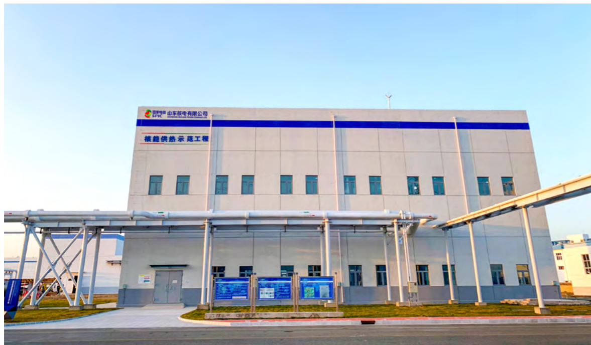
核能供热示范工程
