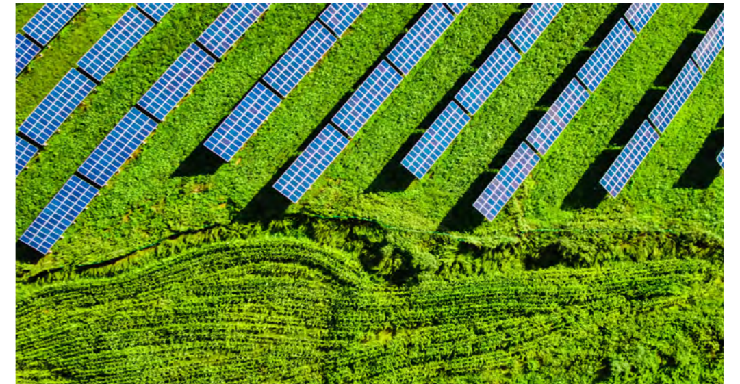
东北地区最大的国家级光伏扶贫电站——吉电股份东北区域公司振发仲安光伏电站
