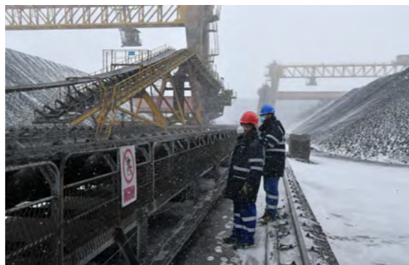
燃料输煤保供工作组在进行输煤系统巡视检查
