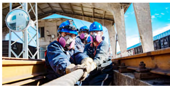
内蒙古公司通辽发电总厂职工在狭窄的地沟里，正在对卸储煤系统翻车机重车铁牛钢丝绳进行检修
