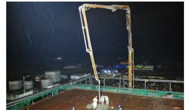
黔东电厂超低排改造施工
