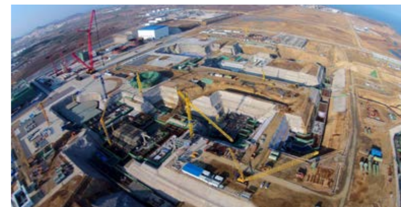
CAP1400 示范工程建设现貌。
