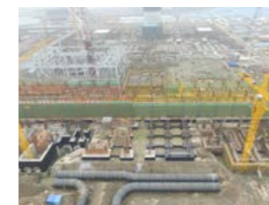
江苏滨海电厂开工建设。
