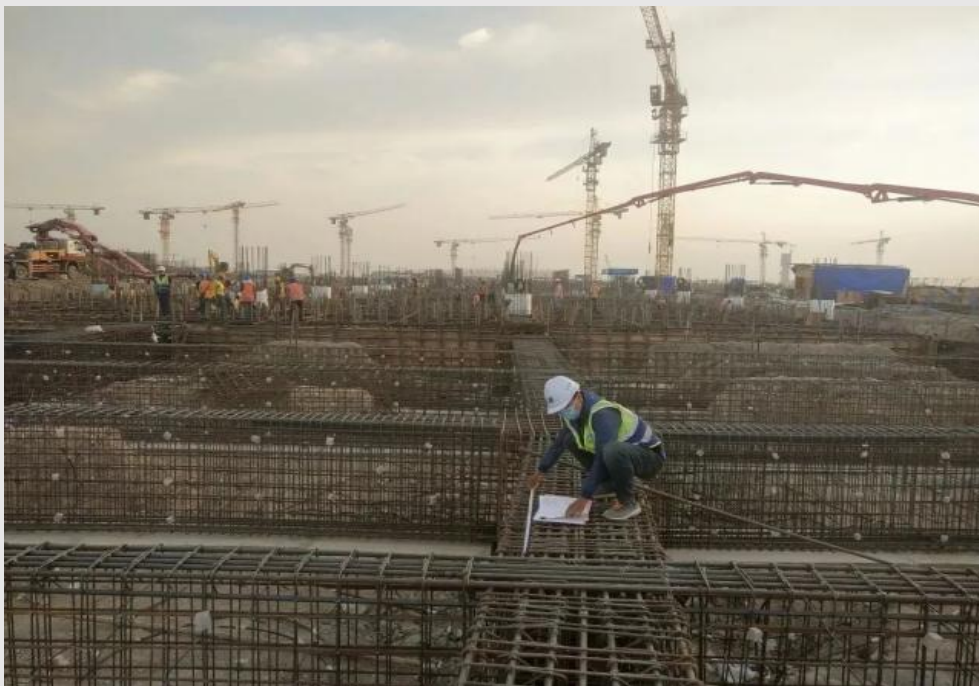
图 24 建筑工程技术专业毕业生姚宇参与金边国际机场建设
