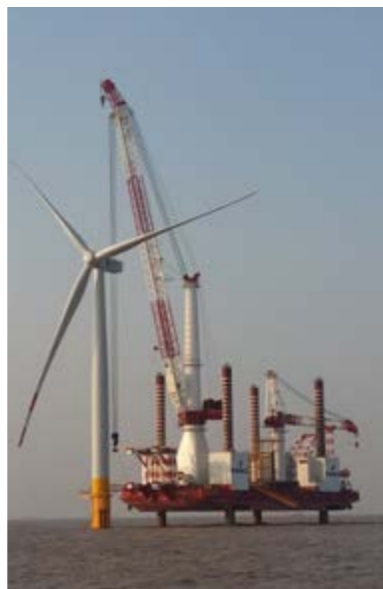
正在建设的江苏海上风电。
