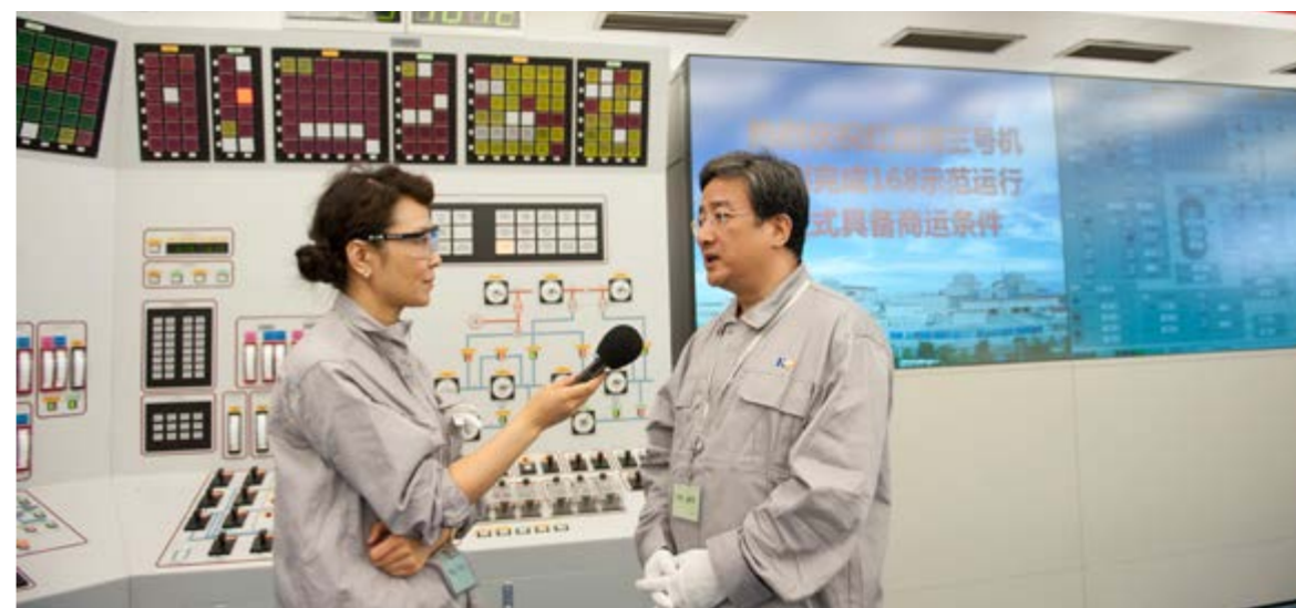
2015年8月16日18时26分，辽宁红沿河核电3号机组结束168小时试运行试验，具备商运条件，国家电投邀请媒体实地采访。
