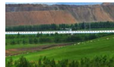
霍林河运煤长廊。
