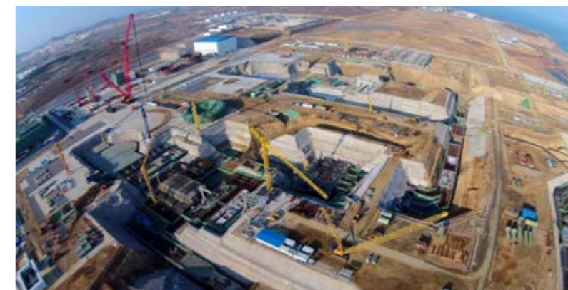
CAP1400 示范工程建设现貌。
