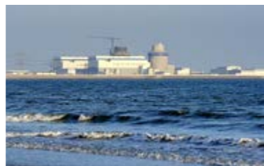
海阳核电站建设现貌。
