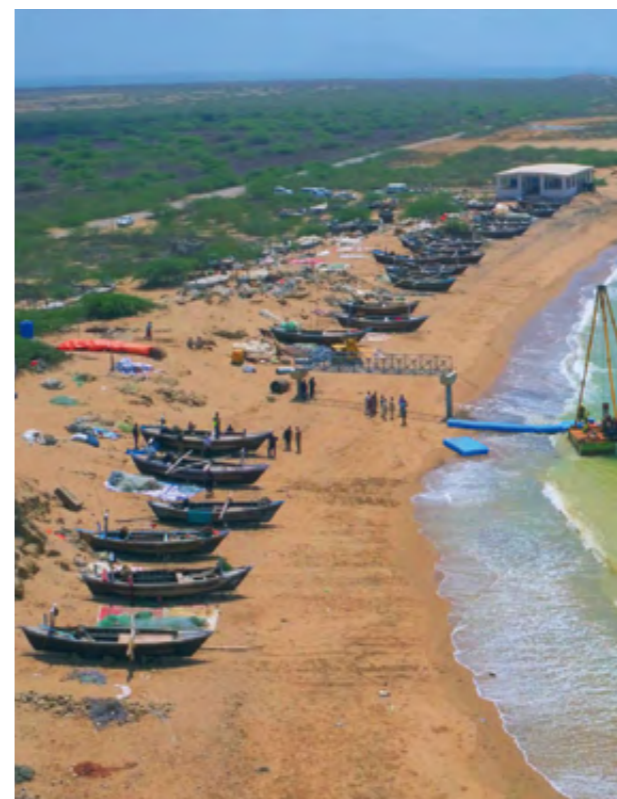
中电胡布渔民码头建设现场
