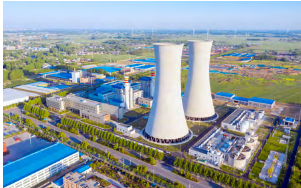
河南公司周口燃气—蒸汽联合循环热电厂工程
