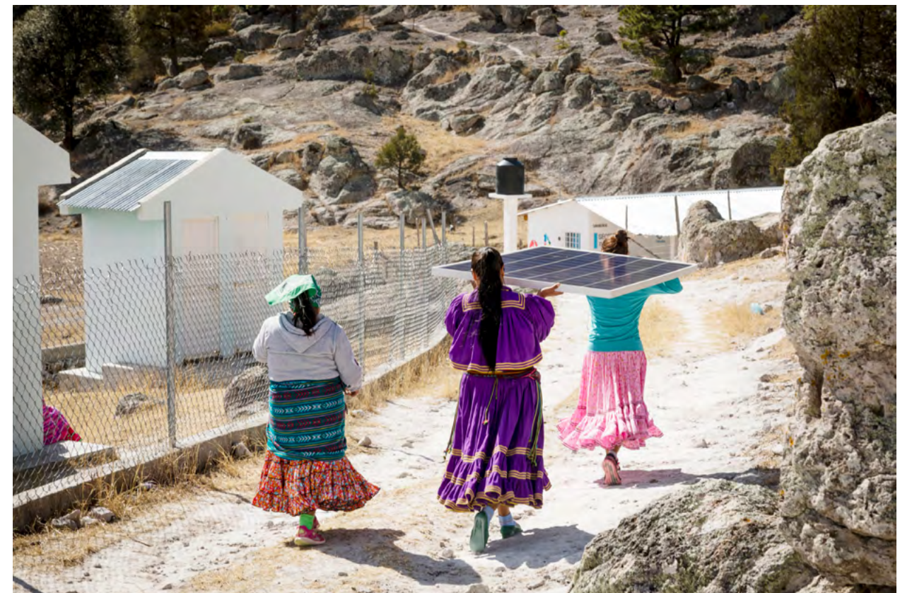
墨西哥 Zuma 项目在贫困地区安装光伏充电系统提升当地生活质量，总受益人数超过 1 万人
