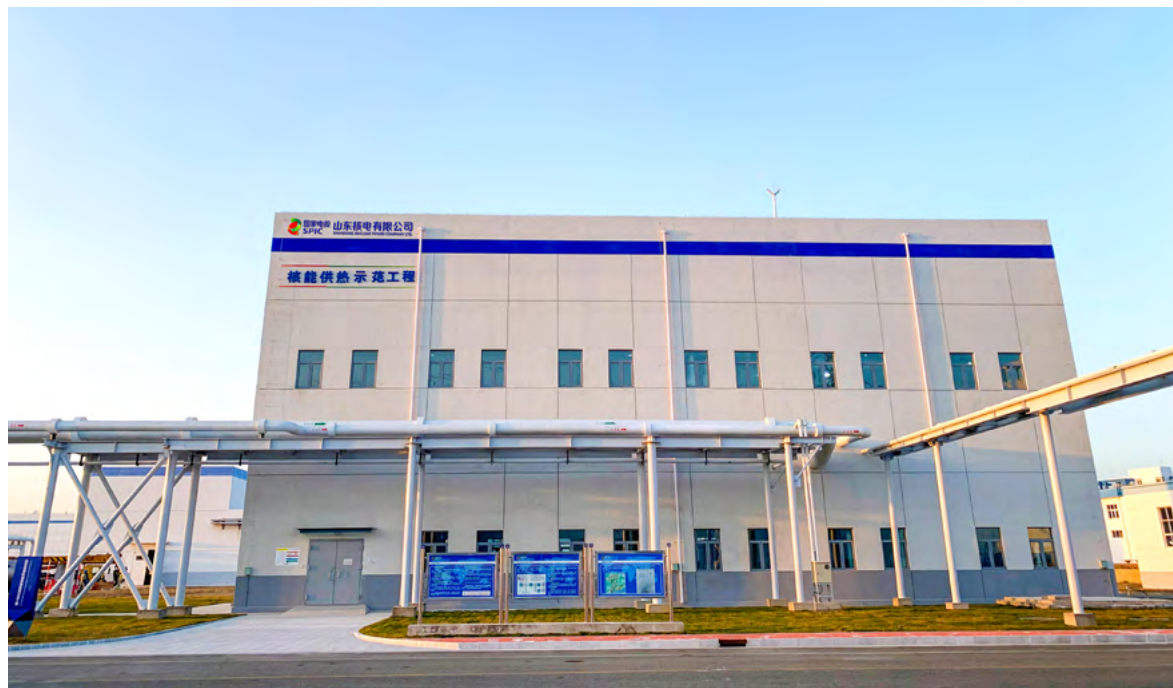
核能供热示范工程
