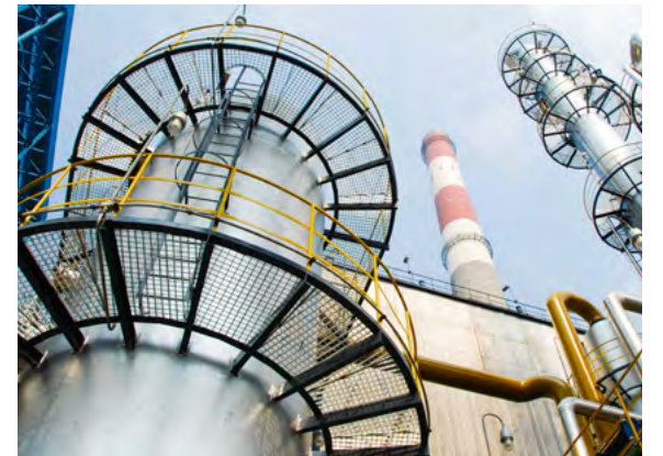
国家电投远达环保万吨级碳捕集装置
