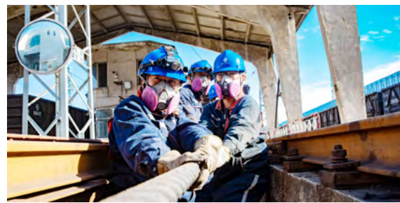
内蒙古公司通辽发电总厂职工在狭窄的地沟里，正在对卸煤系统翻车机重车铁牛钢丝绳进行检修
