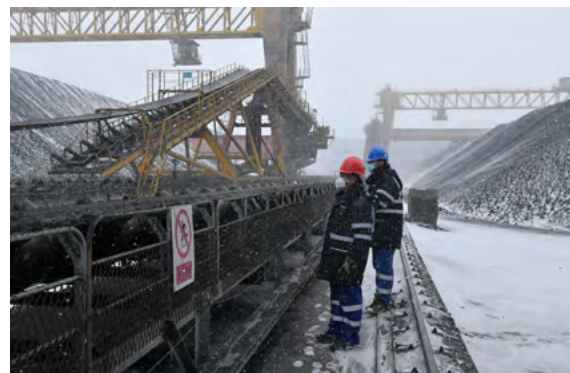
燃料输煤保供工作组在进行输煤系统巡视检查
