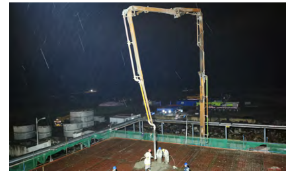
黔东电厂超低排改造施工
