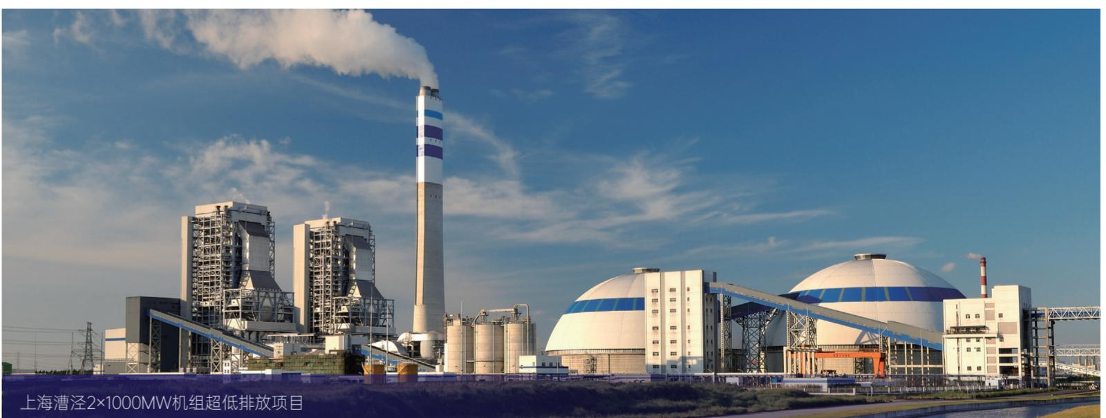
远达环保研发“自适应沸腾式泡沫脱硫除尘装置”，成功应用于121个国内燃煤电厂烟气净化项目，应用机组容量超过60000MW，通过燃煤烟气污染物超低排放，每年可减排粉尘3万吨，二氧化硫7.8万吨。该项专利技术获评“第二十一届中国专利奖”优秀奖。
