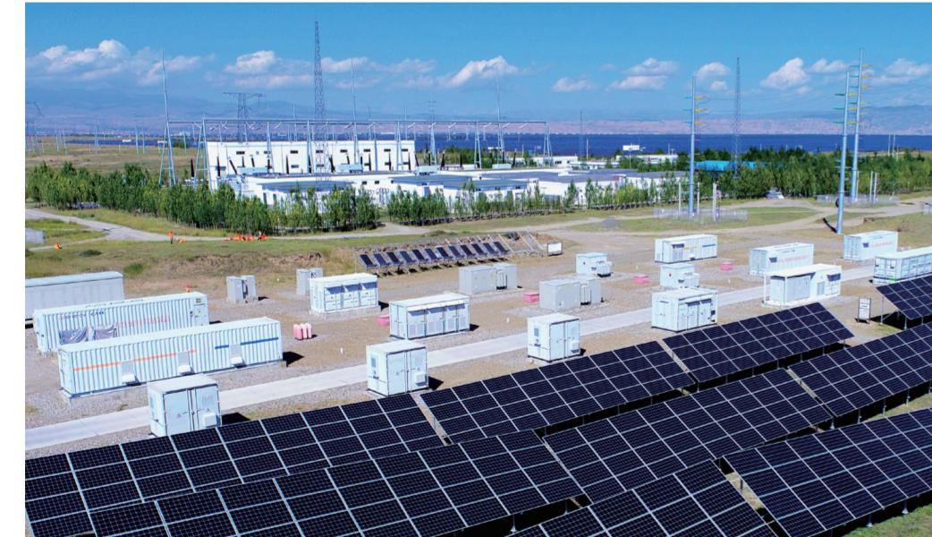
2020年12月，海南州共和光伏产业园的“国家光伏发电试验测试基地配套20MW储能电站”入选国家能源局首批8个科技创新（储能）试点示范项目名单，这是我国首个涵盖所有主流光伏与储能技术路线的项目，项目开展多种储能技术在不同布置方式下与不同光伏发电系统开展联合运行分析，对光伏+储能系统配置方案、设备性能、控制策略与运行效果等进行验证，为整个行业提供了“新能源+储能”系统构建和运行控制的实践基础。
